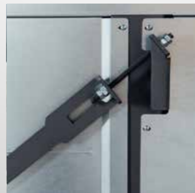
Cięgno na którym podwieszona jest stabilna rama
