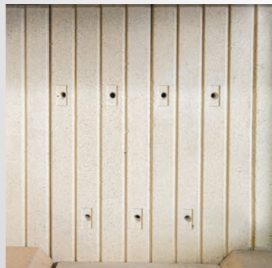
Komora spalania z dopalaniem wtórnym.
